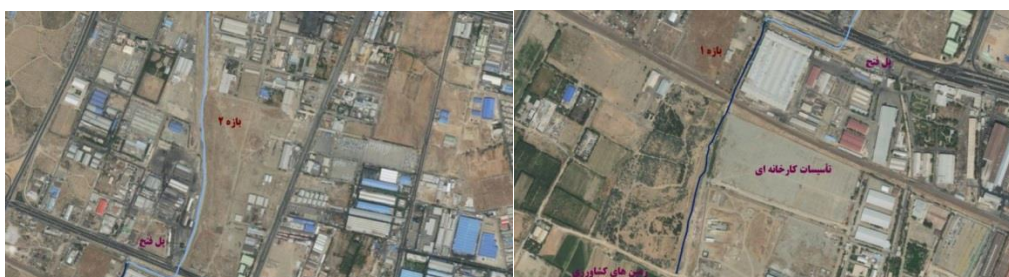
شکل (۴). تصویر هوایی مسیر بازه ۱
