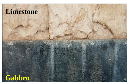
شکل ۳. آسیب زیباشناختی به سنگ نمای ساختمان به دلیل برخی فرایندهای زوال مانند آلاینده‌های اتمسفری و شوره‌زدگی Fig. 3. Aesthetic damage to building facade stone due to some deterioration processes such as atmospheric pollutants and efflorescence
