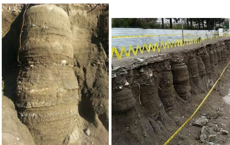
شکل ۶. برداشتن خاک اطراف ستون‌ها به‌منظور کنترل قطر
