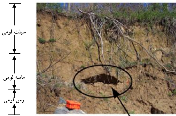
فرسایش ناشی از تراوش
